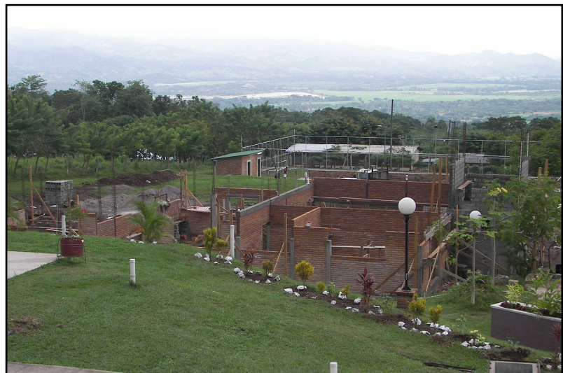
Bau der neuen technischen Lehrwerkstatt
